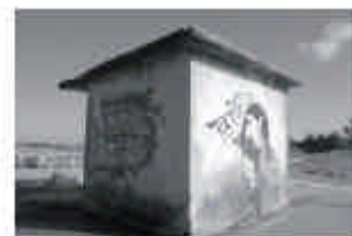
★船を引き上げるウインチ小屋
